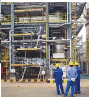
南京扬子巴斯夫SCR（氨法选择性催化还原），垃圾焚烧炉尾气脱硝用高温烟换热器（替代GEA）。
