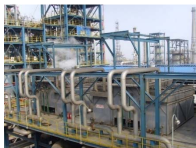
华北石化 60 万吨/年连续重整汽轮机乏汽冷凝器
