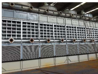
延安能化项目
