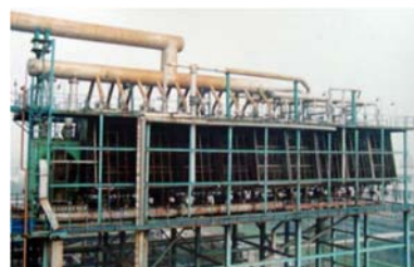
兰炼 2#蒸馏减顶板式湿空冷器
