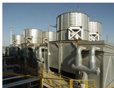
克拉玛依 20 万吨/年甲醇装置汽轮机乏汽冷凝器
