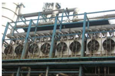
广州 800 万吨/常减压装置减顶板式空冷器
